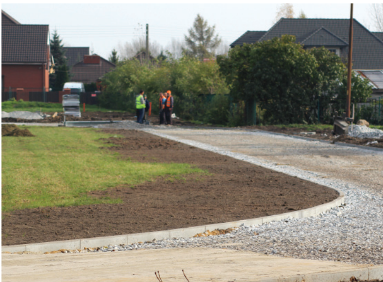
Budowa kompleksu sportowego pod nazwą „Królowa Sportu” przy Centrum Kształcenia Zawodowego i Ustawicznego.
