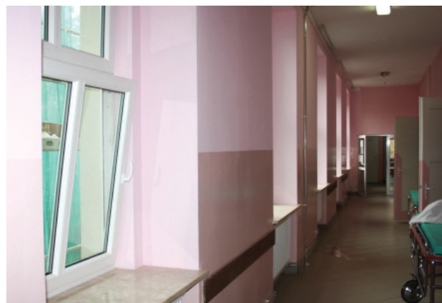
Wyremontowany oddział położniczy m.in. nowe okna i parapety.
