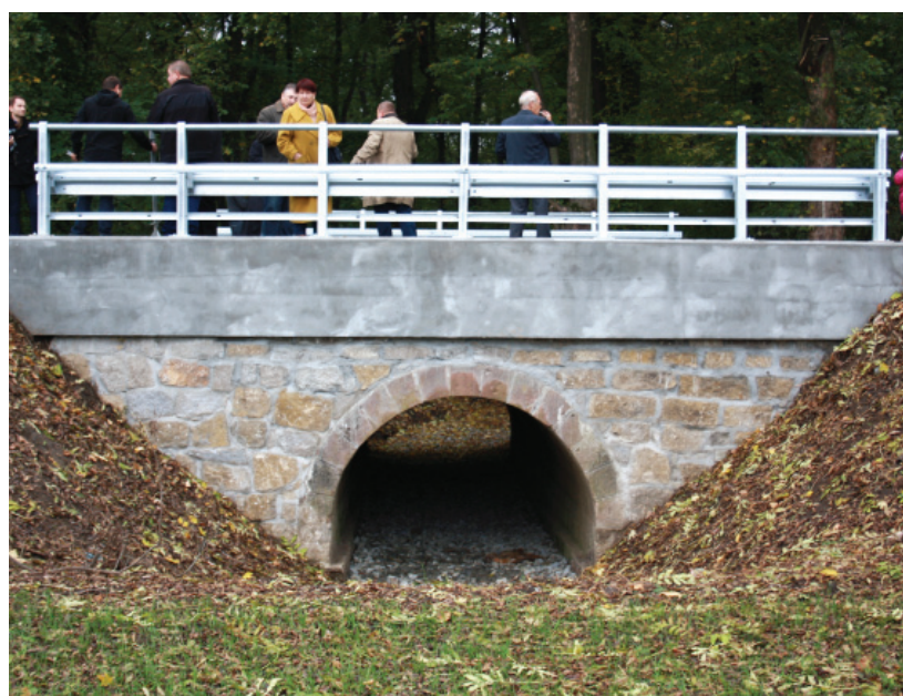
Jeden z dwóch wyremontowanych mostów w Bierzynie.
