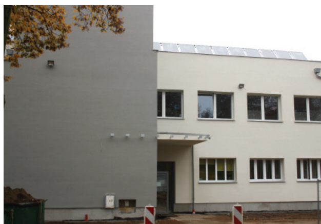
Remont przychodni POZ i montaż systemu solarnego.
